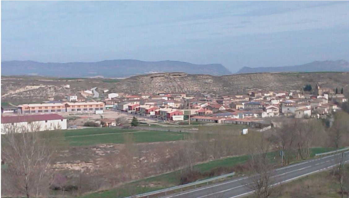
Fig 3. Panorámica del pueblo de Ochánduri, donde se pueden observar varios tejados fotovoltaicos
