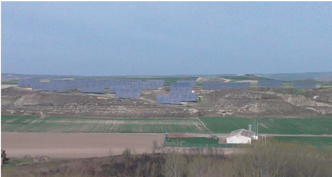
Fig 2. Panorámica de los 700 kWp instalados en la fanega solar Ochánduri
