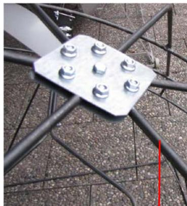
La conexión central (15) consiste de dos placas que unen los 6 conectores de anillos (8)
