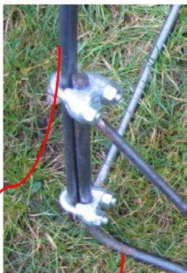
Conección del puntal vertical (2) con base (3) utilizando abrazaderas (20) (si no soldado)
