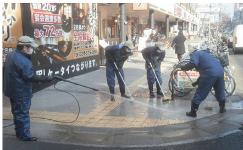
Descontaminación de zonas del centro de la ciudad utilizando equipo de limpieza de alta presión. Febrero 2012. Foto: JANIC
