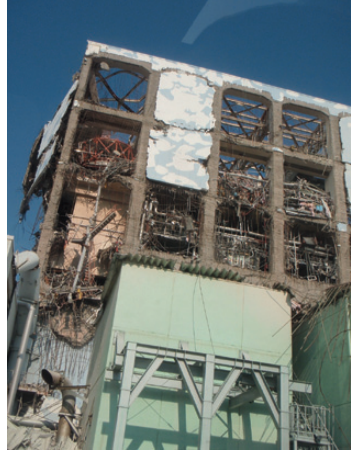
Reactor 4 de la planta de energía nuclear Fukushima Daiichi, destruida en el accidente de julio del 2011 Foto: JANIC
