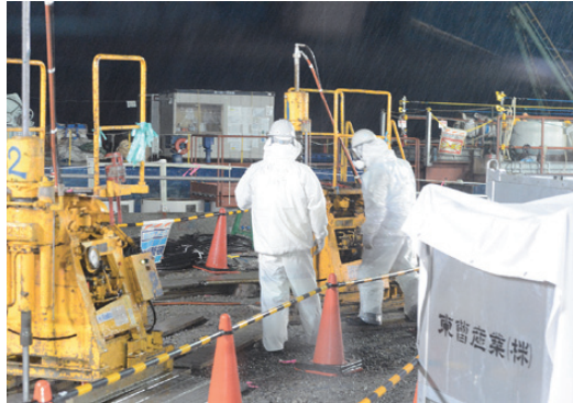
Labores post-desastre dentro de la planta nuclear Daiichi en Fukushima. Julio 2013
